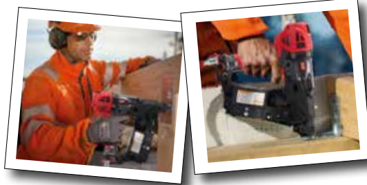
Fixation des sabots / connecteurs métalliques.
